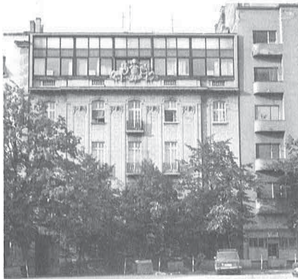
Stambeno-poslovna zgrada u Njegoševoj ulici u Beogradu
